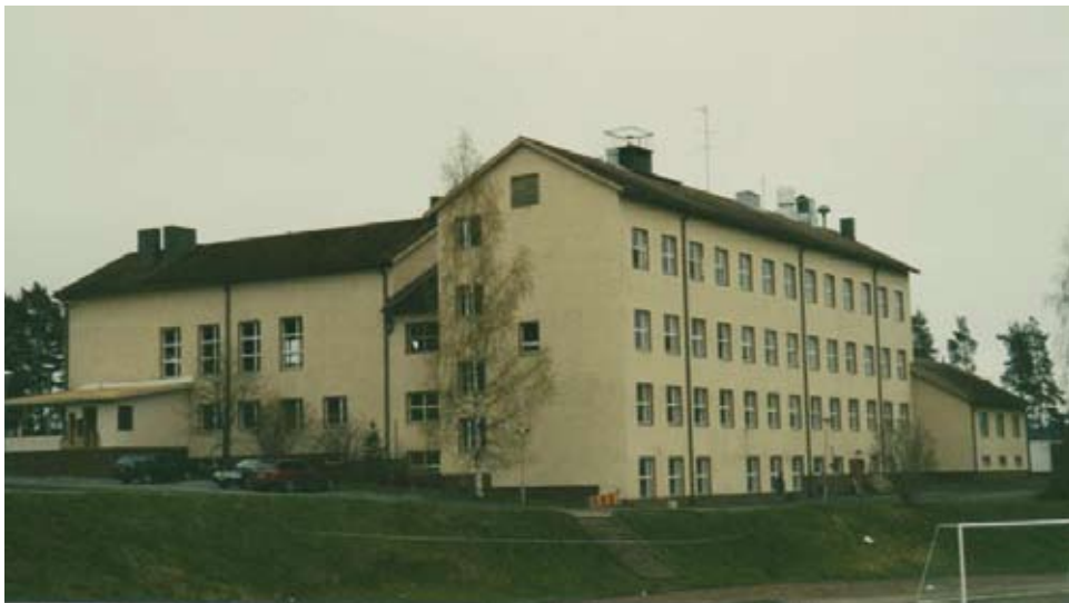
Kuva 1. Keski-Suomessa sisäilmaongelmien takia purettu koulurakennus.
